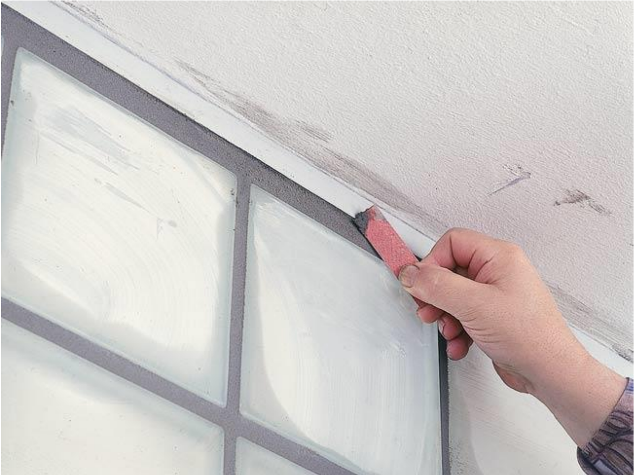
Un pezzetto di legno consente di spianare zone mal rifinite pareggiando le commessure.
