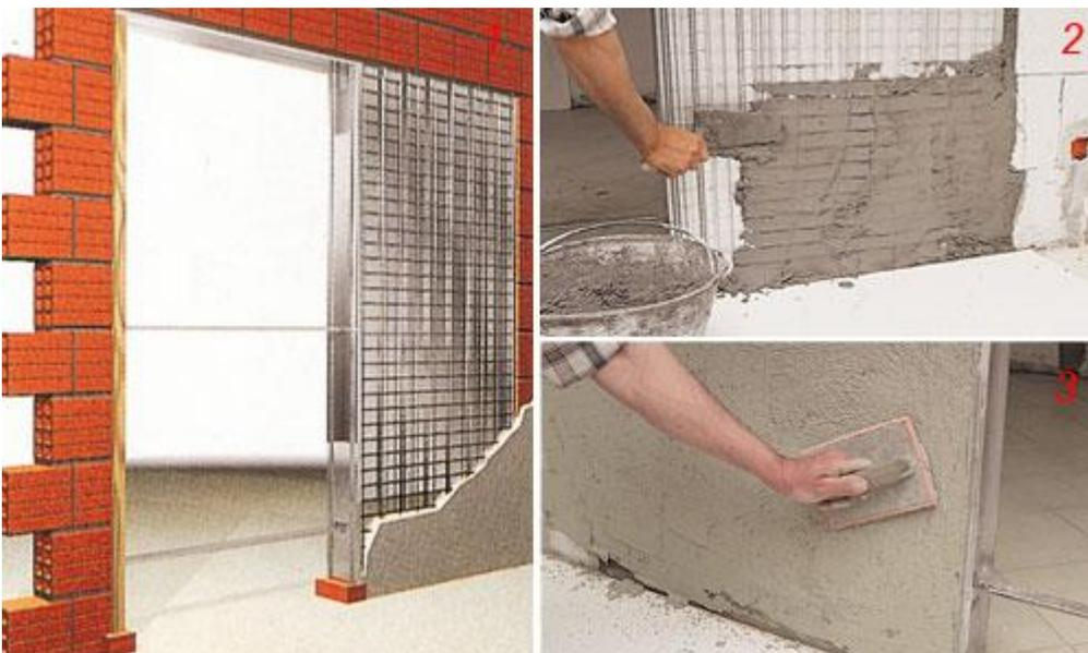
1. Il cassonetto in cui sparisce la porta sostituisce una porzione di muro e, una volta intonacato, diventa tutt'uno con la parete. Per montare la struttura in bolla e lasciare una
