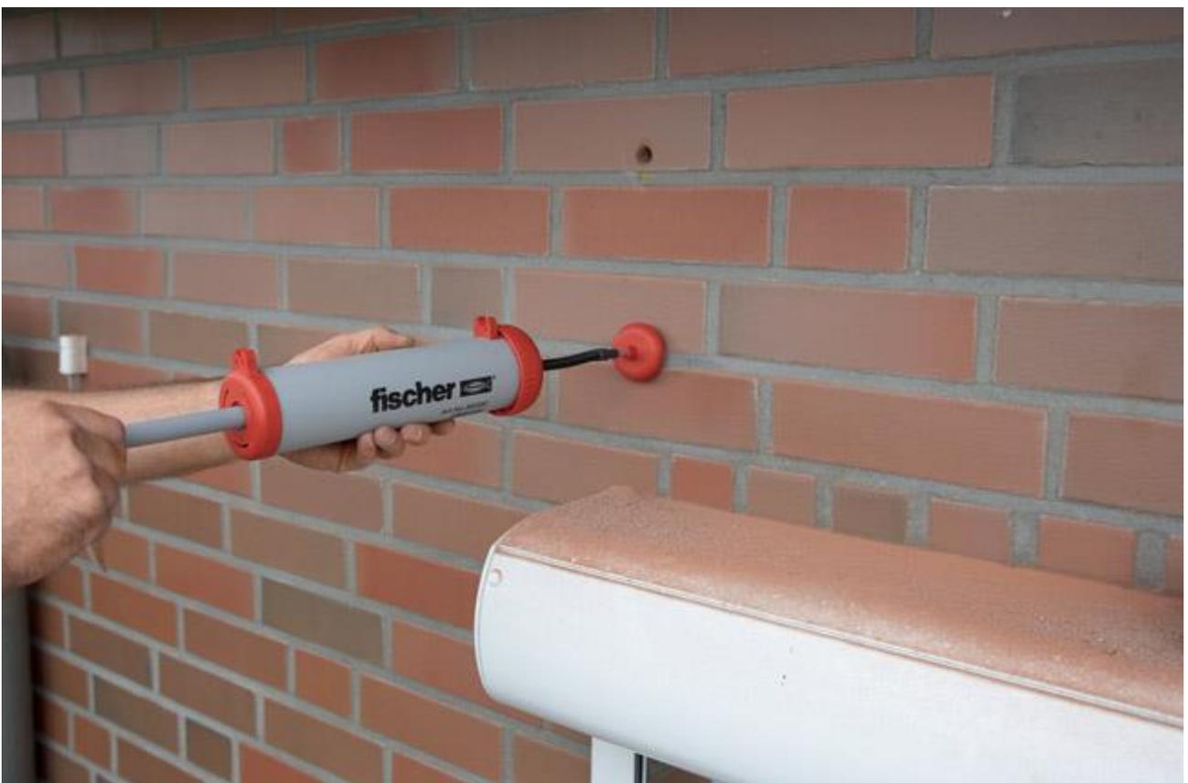
I fori vanno ripuliti dalla polvere insufflando aria all'interno; quest'operazione è particolarmente importante con l'uso di ancoranti chimici.
