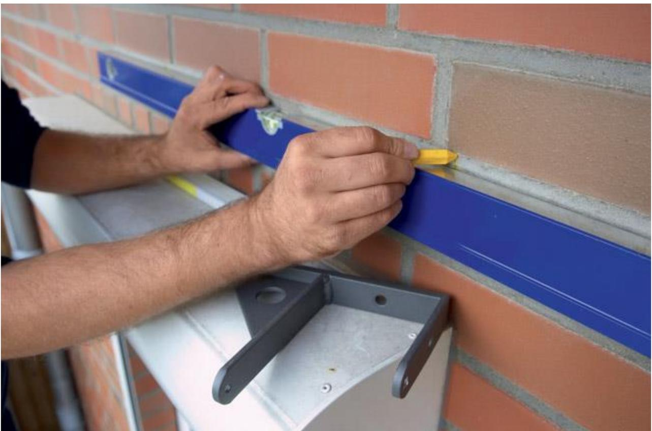
Bisogna tracciare la linea di colmo della tettoia sul muro, tenendo conto che l'inclinazione verso il basso non disturbi l'apertura di scuri o persiane.
