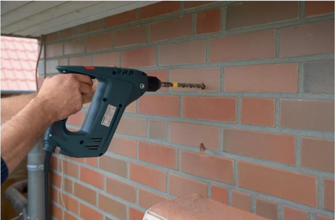
Stabiliti i corretti interassi per il fissaggio delle mensole, si praticano i fori per i tasselli con il trapano a percussione ed una punta da muro di diametro adeguato; la profondità dev'essere almeno di 5 millimetri superiore alla lunghezza dei tasselli.
