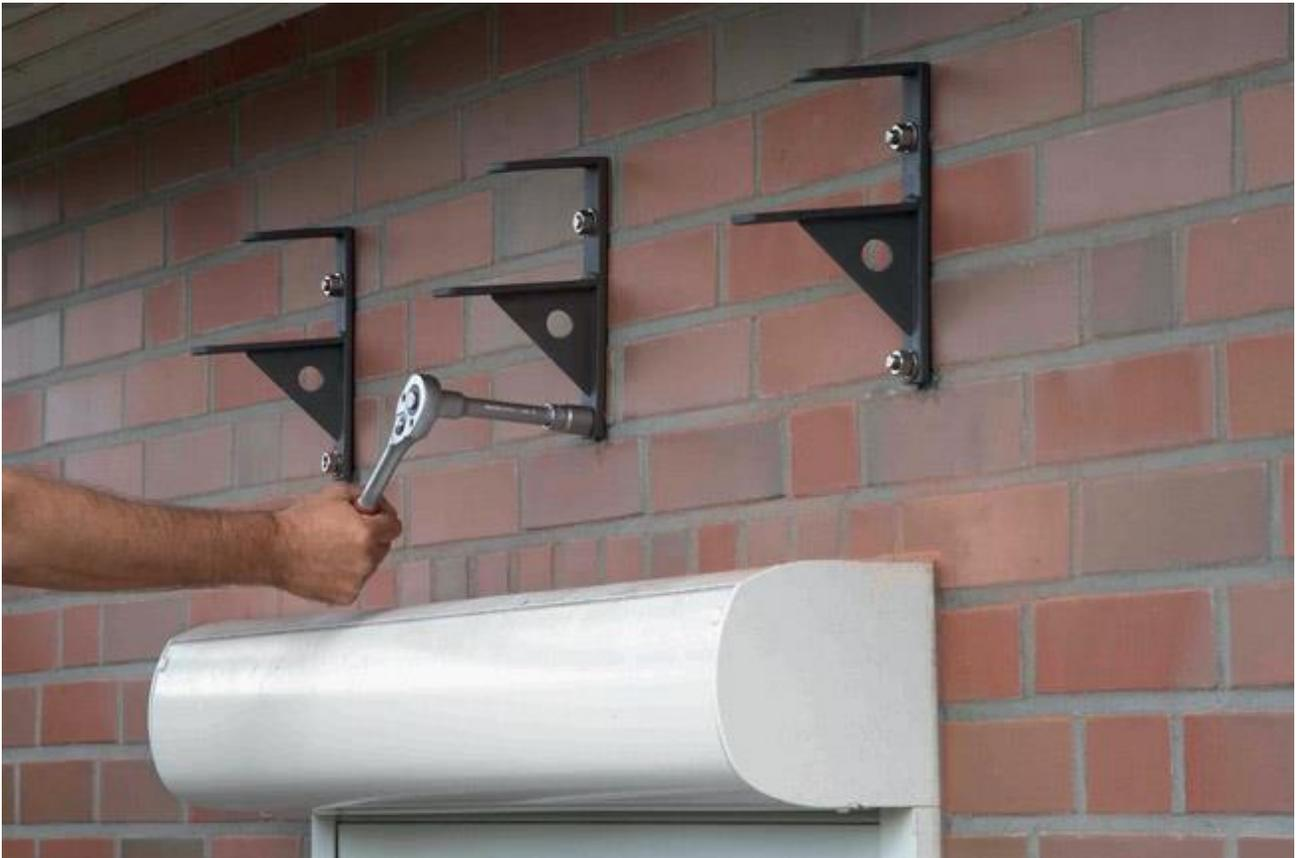
Se si utilizzano tasselli ad espansione, questi vanno tirati fino alla massima tenuta, senza esagerare se il supporto è di materiale poroso e leggero (cemento cellulare o arenaria). Utilizzando tasselli chimici, dopo il riempimento del foro con l'ancorante (con o senza calza) si inserisce la barra filettata ruotandola per impastarla e si aspetta che avvenga l'indurimento prima di calzare la mensola e tirare il dado.
