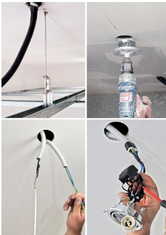
Nelle controsoffittature di cartongesso si lascia una guaina con i conduttori che esce dal soffitto. Ai conduttori vanno collegati i vari punti luce o il trasformatore, se sono a bassa tensione (vedi schemi in basso).
