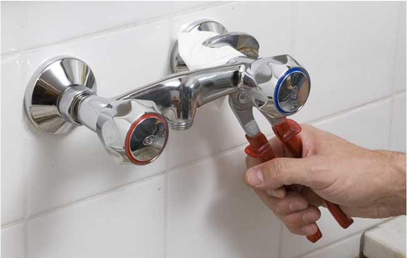
Se siamo stati precisi nel posizionare gli eccentrici, i due dadi di fissaggio del gruppo si avvitano senza sforzo. Stringiamoli con un po' di carta tra le pinze a pappagallo e la manopola rubinetto.
