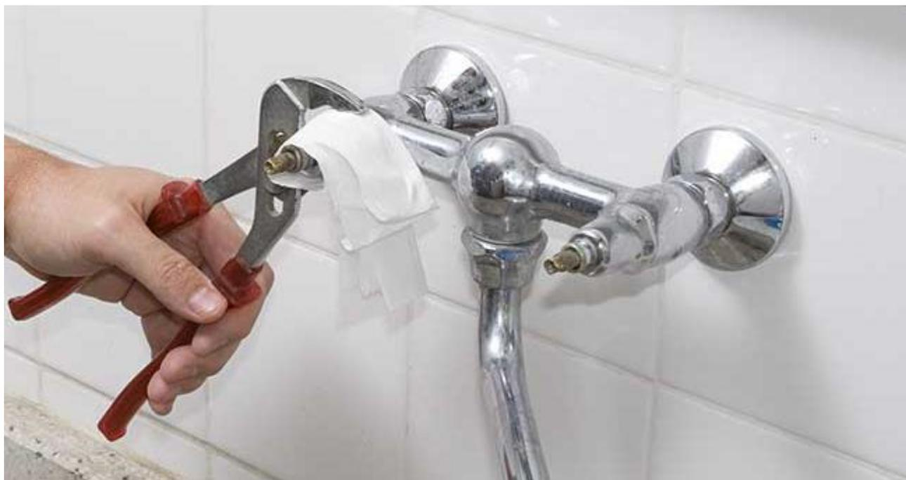
Tolte le manopole per smontare rubinetto miscelatore, si svitano le campane; per non rovinarle con le pinze a pappagallo (non sappiamo ancora se si deve sostituire il tutto) non serriamo direttamente sulla cromatura, ma interponiamo un po' di carta.
