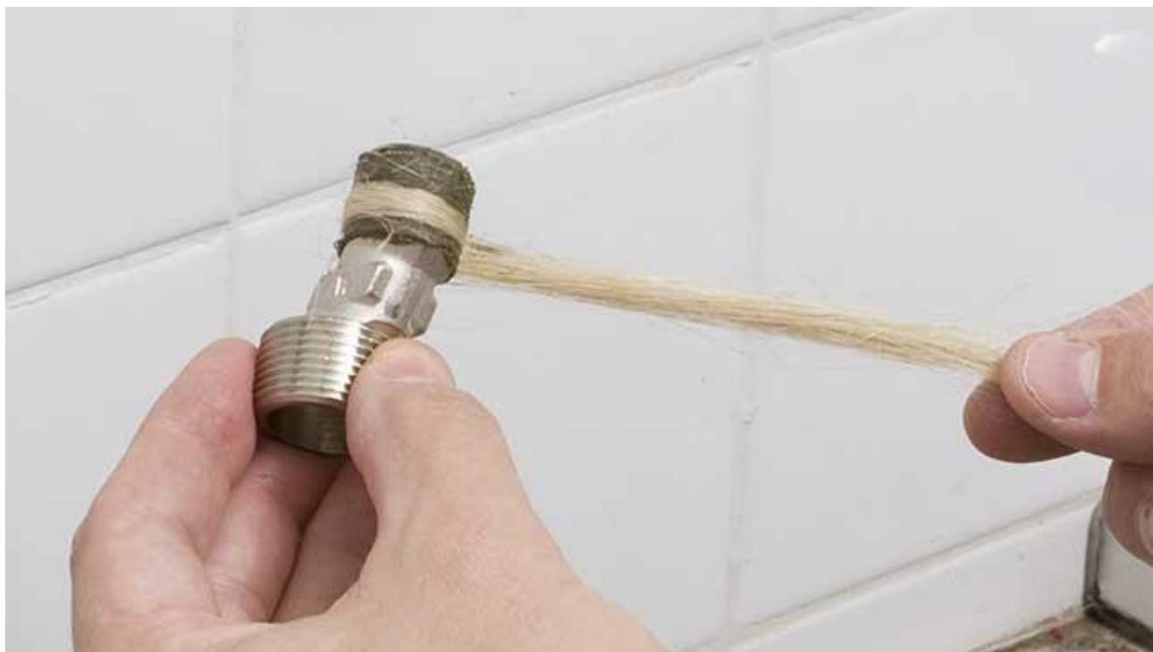
Non è possibile dire quanta canapa ci voglia per una filettatura; le prime volte si tende ad eccedere e, avvitando (con fatica) il pezzo, vediamo che ne fuoriesce parecchia. Basta fare qualche prova e si impara subito.
