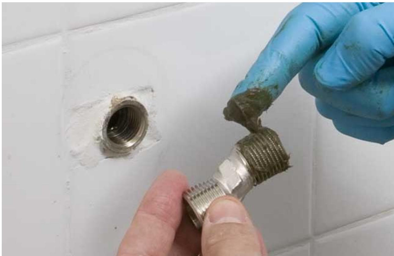
PER capire come sostituire un rubinetto, dato che la vecchia posizione del gruppo bullone muro non va bene per il nuovo gruppo, abbiamo optato per il montaggio di quelli inclusi nella confezione. Una ditata di pasta idraulica predispose il filetto a ricevere la canapa.
