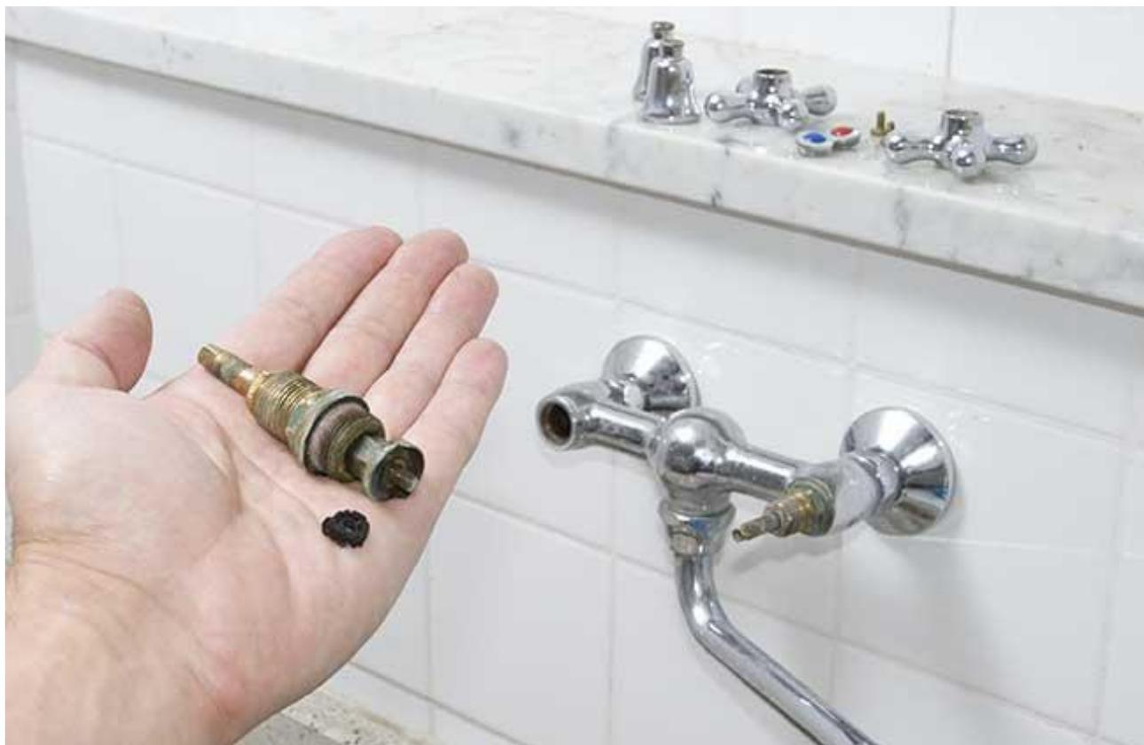
Con le pinze svitiamo anche il vitone in modo da poterne controllare lo stato; nel nostro caso non è riparabile e non è sostituibile.
