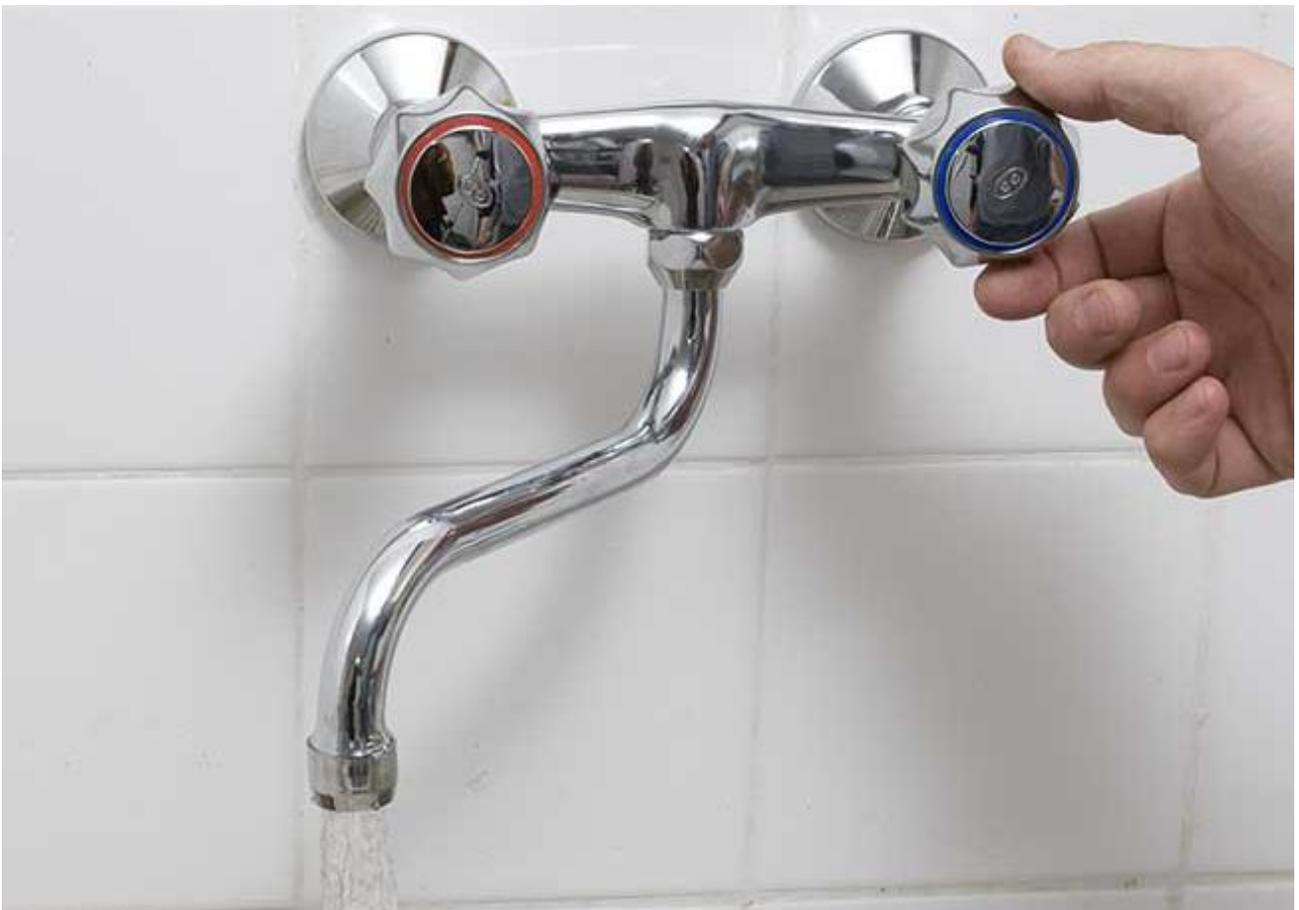
Una volta avvitato il tubo erogatore con in cima il rompigitto, possiamo riaprire il rubinetto principale dell'acqua e verificare la tenuta delle guarnizioni e il funzionamento.
