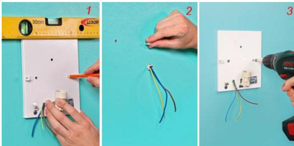
1. Poggiamo la piastra al muro, posizionandola in corrispondenza della guaina che fuoriesce dalla parete, e tracciamo i punti da forare mantenendola in orizzontale con la livella a bolla.
